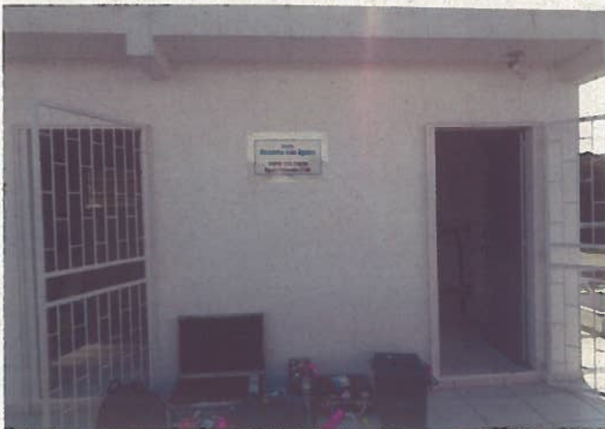
Casa de Proteção
